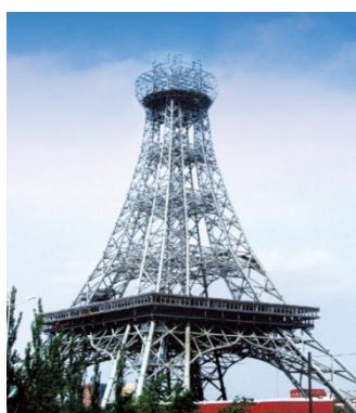
冶建最高标志性建筑物 巴楚电视台
